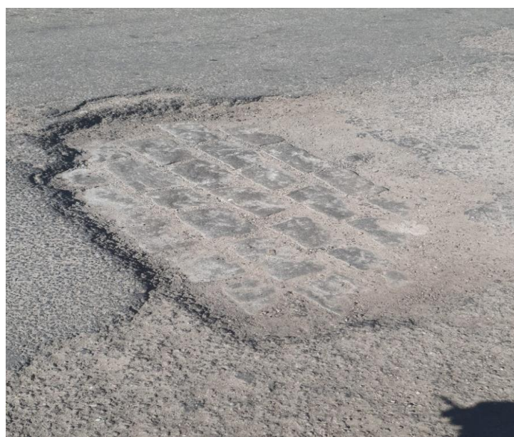
Rua Paquequer, Bom Retiro. Recapeamento, CBUQ, 5cm.
