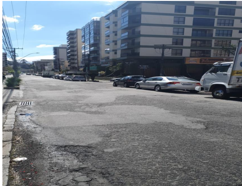
Rua Rui Barbosa, Várzea. Recapeamento, CBUQ, 5cm.
